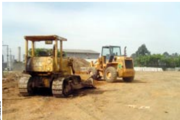
Rua da Lagoa está prestes a ser pavimentada
