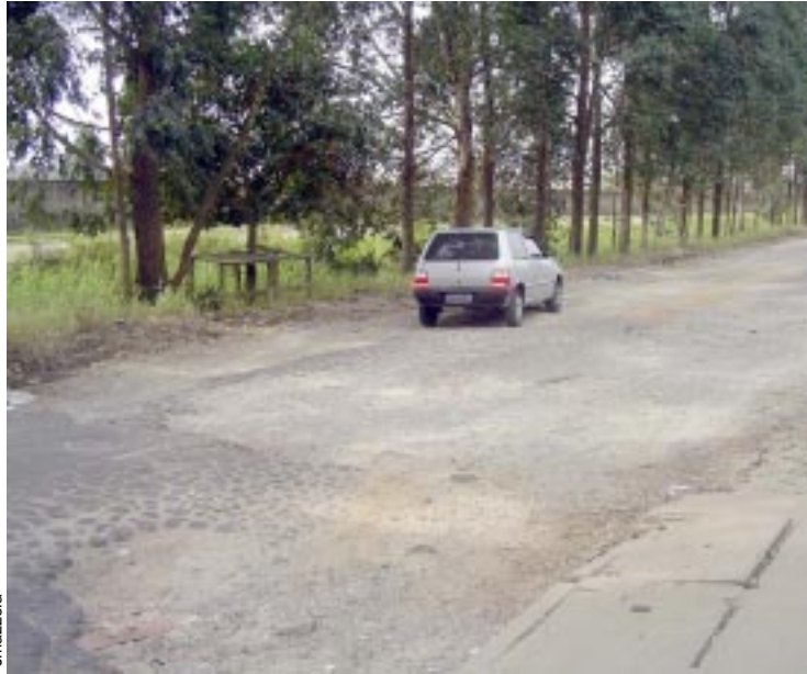
Panambi: deterioração no solo será reparada
