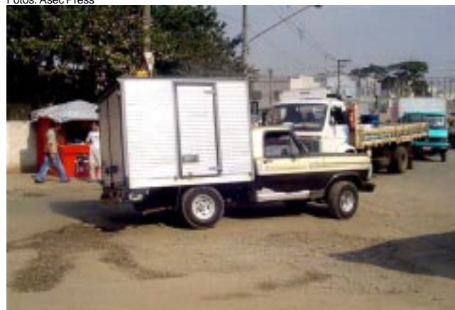
Caminhão no buraco da rua Baixio
